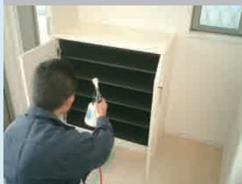
消臭抗菌施工
